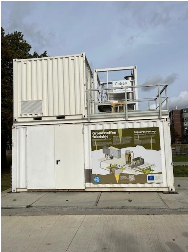
Figuur 44: Vacuümstation met vergister voor behandeling zwart water
