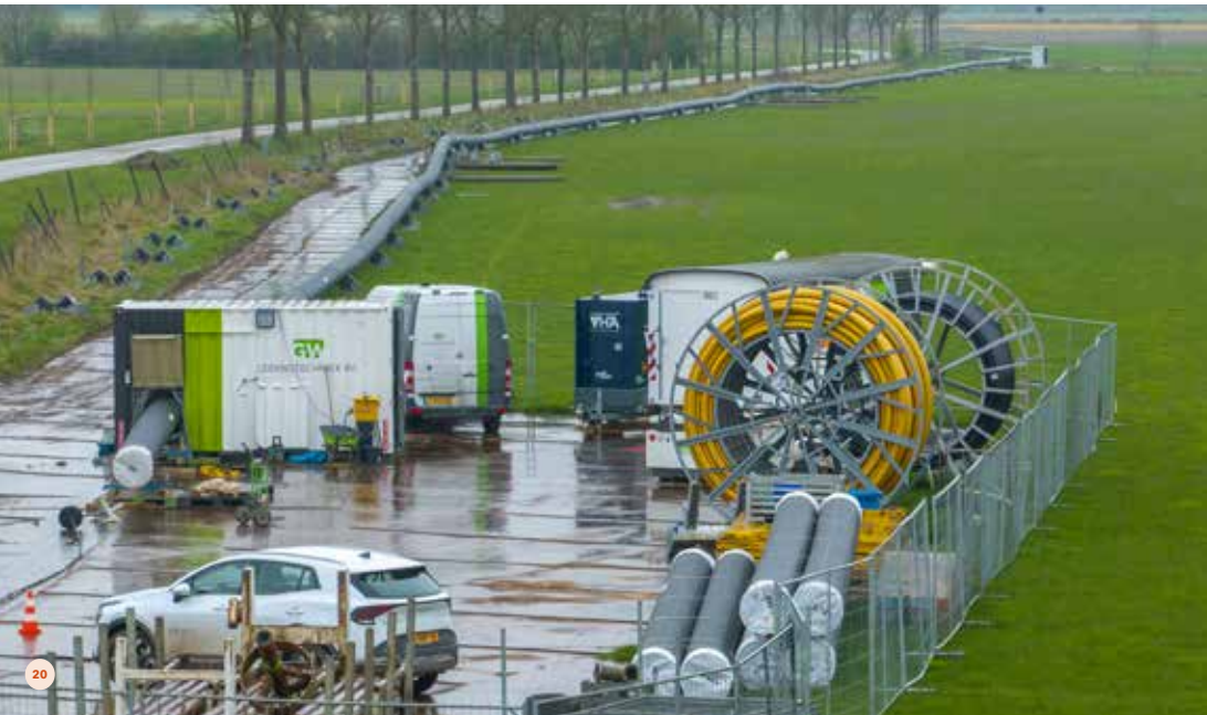
20 21 Verleggen van kabels en leidingen – Maart 2024
