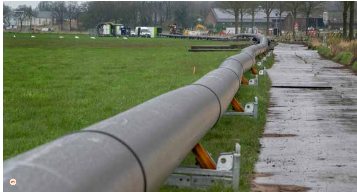
22 Met een horizontale gestuurde boring is een leiding met een lengte van 660 meter 15 meter onder maaiveld aangelegd – Maart 2024
