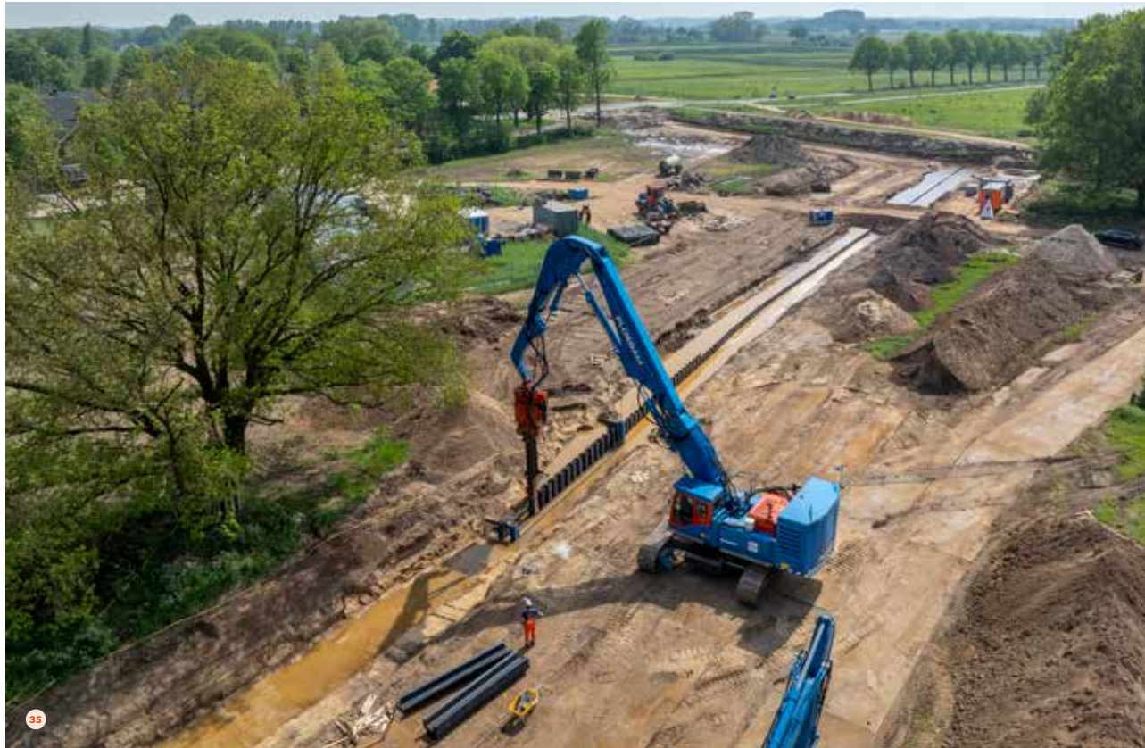
35 36 Damwanden aanbrengen – Juli 2024
