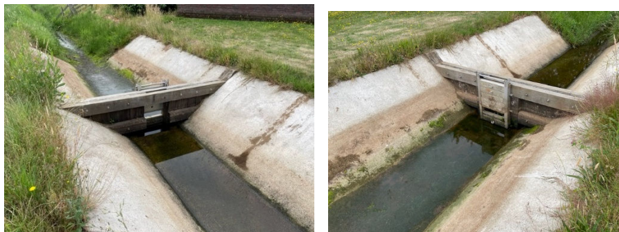
Figuur 4-3a Foto van envelopstuw nabij het retentiebekken in de Belfelderbroekbeek
