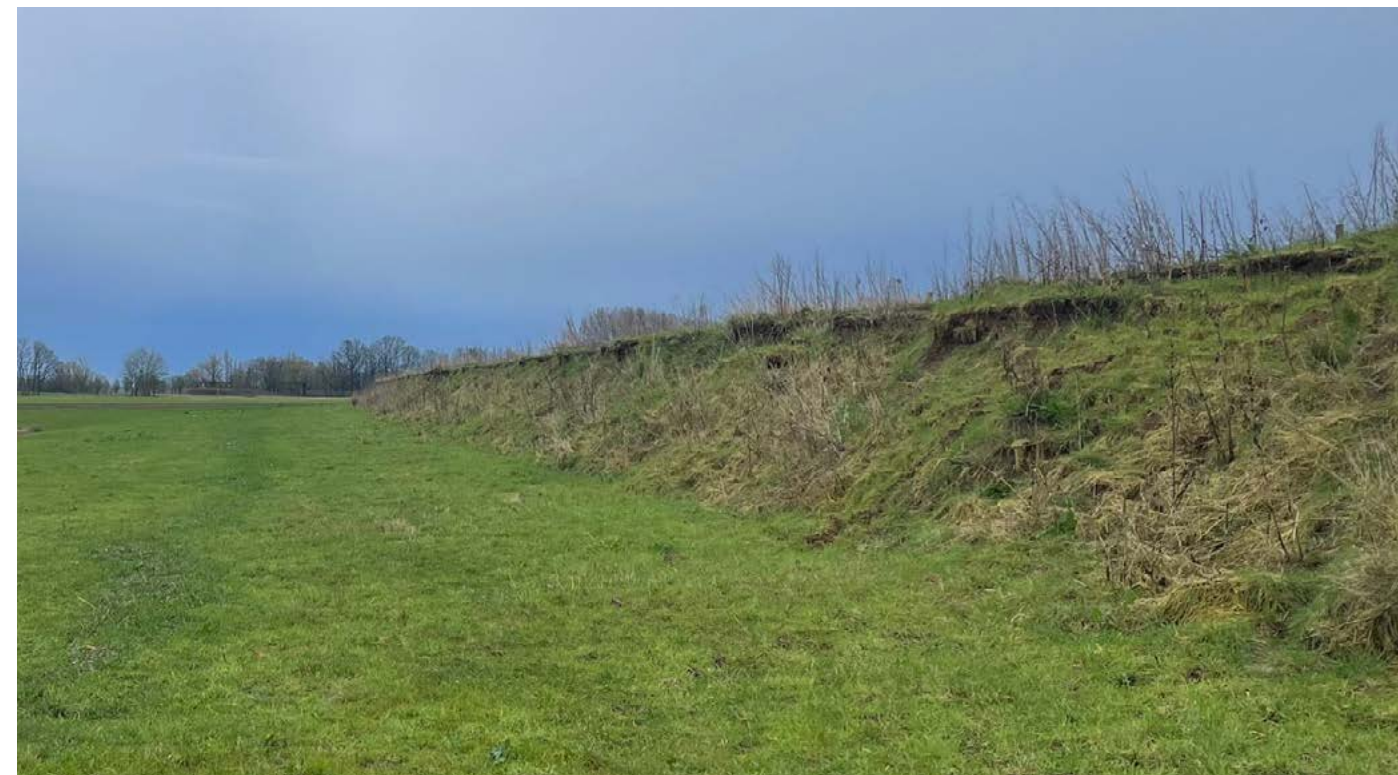
Figuur 71. Referentiefoto: Erosie buitentalud steilranddijk Ooijen Wanssum; bron: Waterschap Limburg
