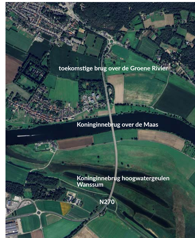
Figuur 114. Luchtfoto met de bruggen in de N270: centraal de prominente Koninginnebrug over de Maas, aan weerszijden meer ingetogen bruggen over de hoogwatergeulen; bron: google maps
