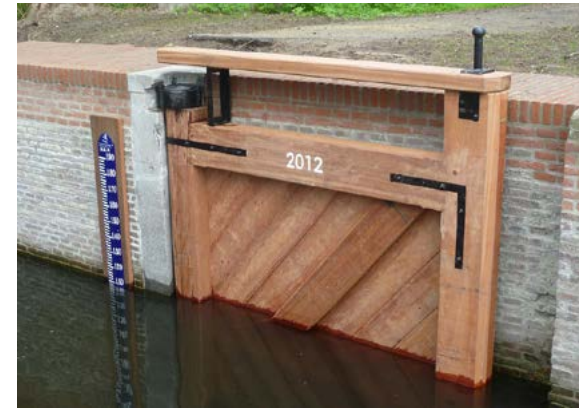
Figuur 74. Referentiefoto van een coupure met vaste deuren geïntegreerd in de muur
