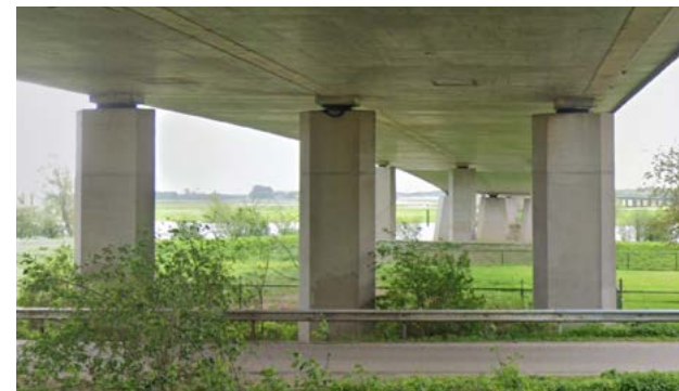
Figuur 127. Steunpunten bestaande Koninginnebrug; bron: google earth
