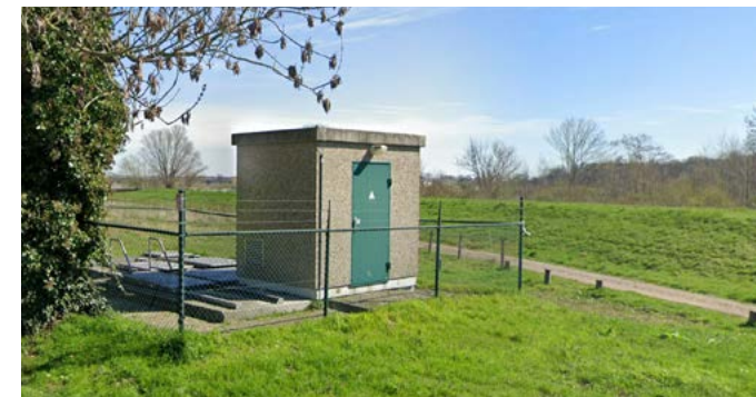
Figuur 130. Foto bestaand rioolgemaal; bron: google earth
