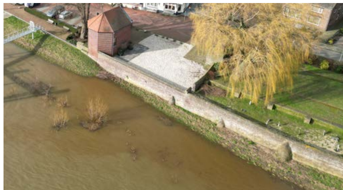
Figuur 95. Luchtfoto van de bestaande situatie van de kerkhofmuur Oud Well.
