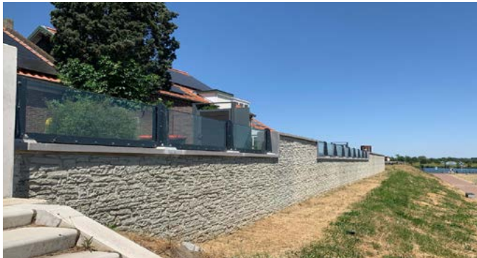
Figuur 106. Referentiefoto glazen kering niet optelsom van technische eisen. Ambitie is een zo rank en ingetogen mogelijk beeld; bron: Waterschap Limburg
