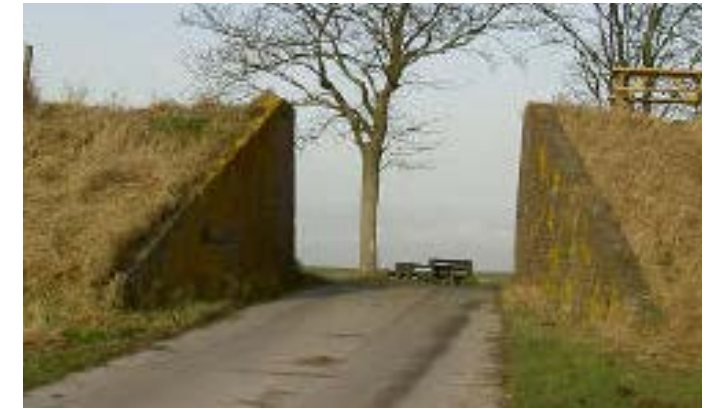
Figuur 75. Referentiefoto van een coupure met wangen van metselwerk, meelopend met de taludhellingen.
