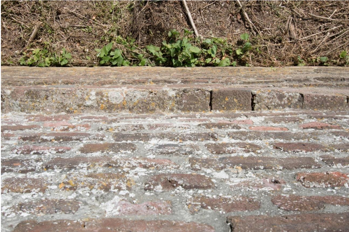
Staande op de muur, zijn de versnijdingen in beeld te brengen.
