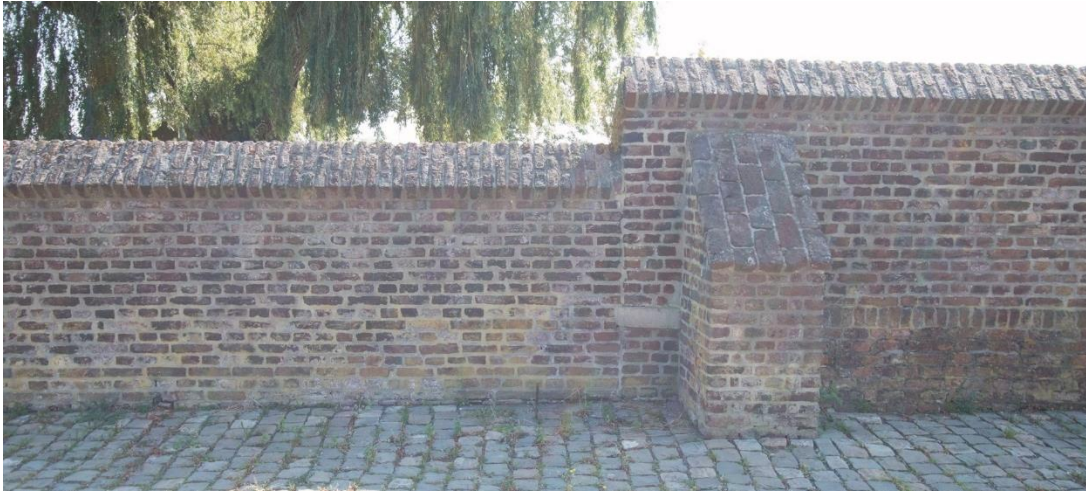
Aansluiting van de kerkhofmuur (links) op het fundament van de vermoedelijk achttiende-eeuwse (en in 1841 vernieuwde) zijbeuk van het schip (rechts). Op basis van oude foto's moet links op deze opname tot aan de oorlog een toegang tot het kerkhof zijn geweest.
