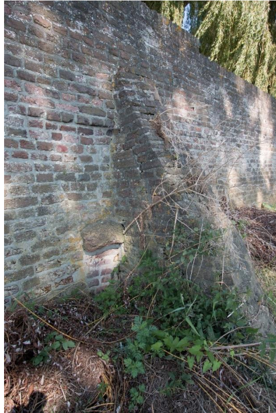
De linker van de twee steunberenlijfsbrekers in vooraanzicht en overhoeks (met spuigat). Op de rechter opname is vrij duidelijk te zien dat het uitbulken van de muursegmenten de geboorte bij de steunberen heeft, wat een aanwijzing kan zijn dat de beren van oudsher deel uitmaken van de muur.
