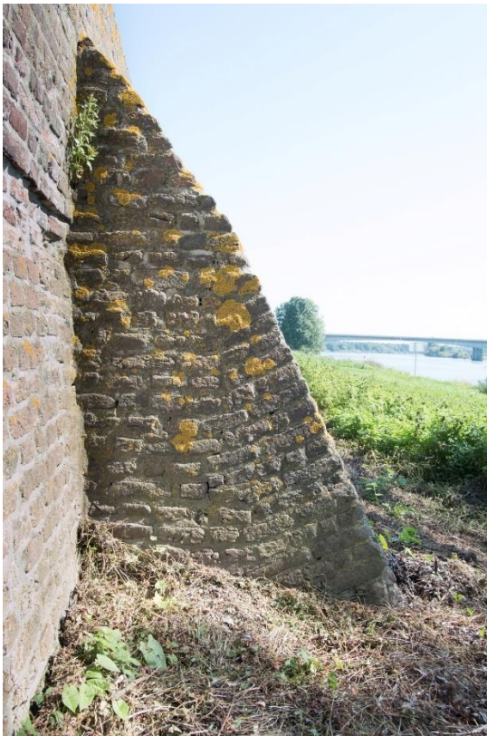
Bij de rechter van de twee steunberenlijfsbrekers is duidelijk te zien dat er geen vlechtingen zijn toegepast. De schuimte van de steunbeer wijkt in de top iets af van het deel daaronder. Dit zou op herstel van de top kunnen wijzen. De algengroei zal het gevolg zijn van de wilg op het kerkhof.
