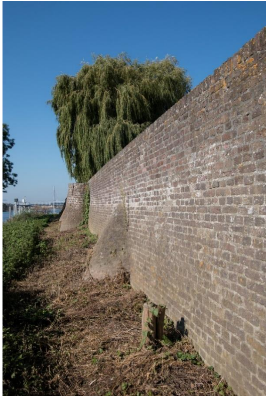
Sectie drie. Het deel van de muur dat de ten behoeve van het kerkhof opgeworpen grond keert, is – zoals te doen gebruikelijk – vier tot vijf graden uit het lood gemetseld. Omdat de grondkerende functie van de muur eindigt op circa 1,1 meter onder te top van de muur, is het in principe niet nodig om de steunberen hoger op te metselen.
