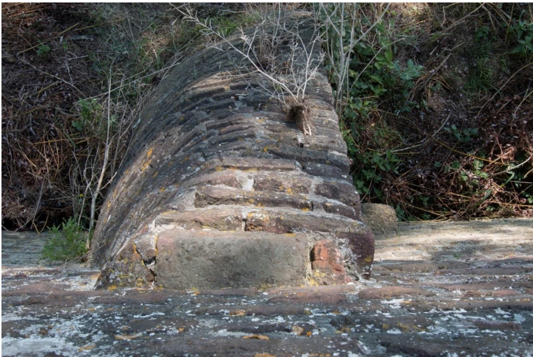
Bovenaanzicht van de linker steunbeerlijfsbreker. De vorm is gekozen om stuwning door hoogwater te voorkomen en misschien ook wel om rommel in het water van de muur af te houden.
