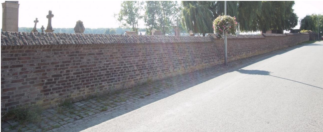
De muur aan de straat in huidige toestand.
