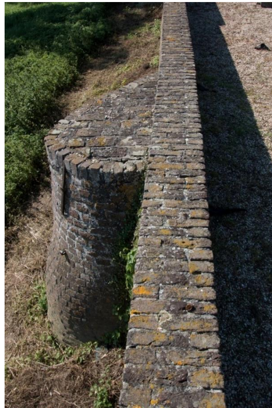
Sectie drie, volgt een recht tracé, met dien verstande dat het lijnelement op het einde (op de hoek) lichtjes inknikt, wat vooral van bovenaf goed is te zien. Op de foto rechts, de aansluiting op de oude hoekbeer van sectie twee, biedt weinig aanknopingspunten voor onderzoek.
