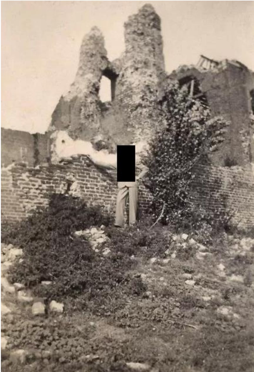
Op deze opname uit 1945 is de oorlogsschade aan muursectie één te zien, alsmede het restant van de gebombardeerde kerktoeren. Aftekening in het metselwerk zou kunnen zijn van een afgescheurde steunbeer, al zou men denken dat in dat geval een kegelvorm zou zijn te zien. Archief Well, alle historie over het dorp Well Limburg
