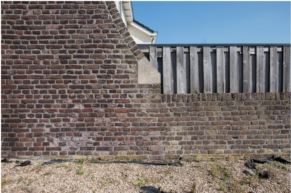
Er is aan de hand van een onderbreking van het metselverband, boven maaivelniveau sprake van een faseverschil tussen het metselwerk uit 1853 (rechts) en het metselwerk van de huidige coulissemuur achter de calvarieberg. Vermoedelijk zijn in de coulissemuur bakstenen hergebruikt. Wellicht bakstenen van het voormalige schoolgebouw (1857) dat direct achter het kerkhof stond.
