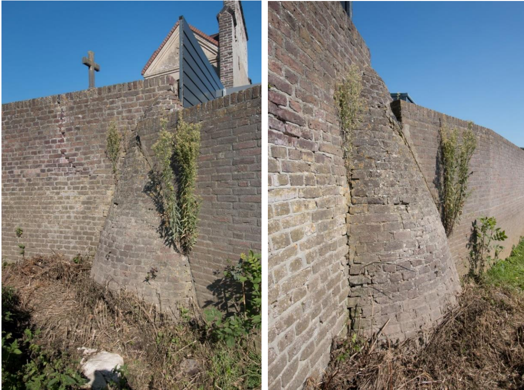
Sectie drie. De beer op de hoek is wel hoger opgemetseld, hier vermoedelijk vooral met een top als muurhoekbescherming bij hoogwater. We zien dit ook bij de voormalige hoek van sectie twee.
