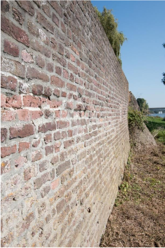
De overgang van het uit het lood gemetselde grond- en waterkerende deel van de muur en de opstand rondom het kerkhof, is duidelijk waarneembaar in muursectie één. De steunberenlijksbrekers ogen betrekkelijk klein, wat mede is bepaald doordat het maaiveldniveau hier relatief hoog is.
