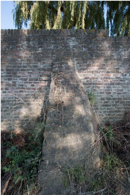
De linker van de twee steunberenlijfsbrekers in vooraanzicht en overhoeks (met spuigat). Op de rechter opname is vrij duidelijk te zien dat het uitbulken van de muursegmenten de geboorte bij de steunberen heeft, wat een aanwijzing kan zijn dat de beren van oudsher deel uitmaken van de muur.
