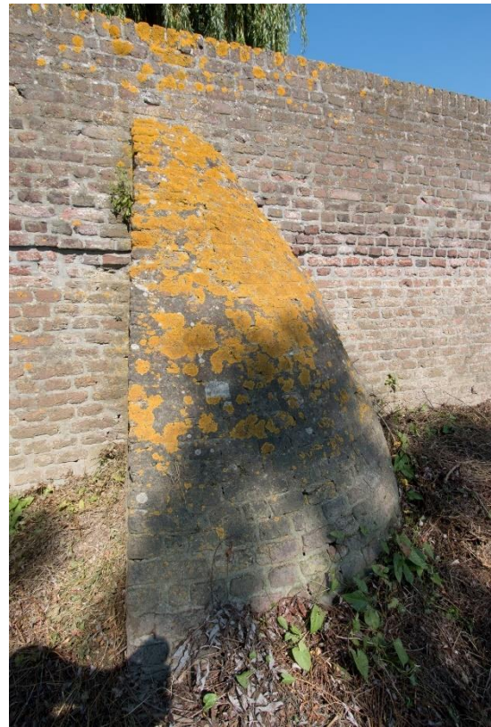
Bij de rechter van de twee steunberenlijfsbrekers is duidelijk te zien dat er geen vlechtingen zijn toegepast. De schuimte van de steunbeer wijkt in de top iets af van het deel daaronder. Dit zou op herstel van de top kunnen wijzen. De algengroei zal het gevolg zijn van de wilg op het kerkhof.
