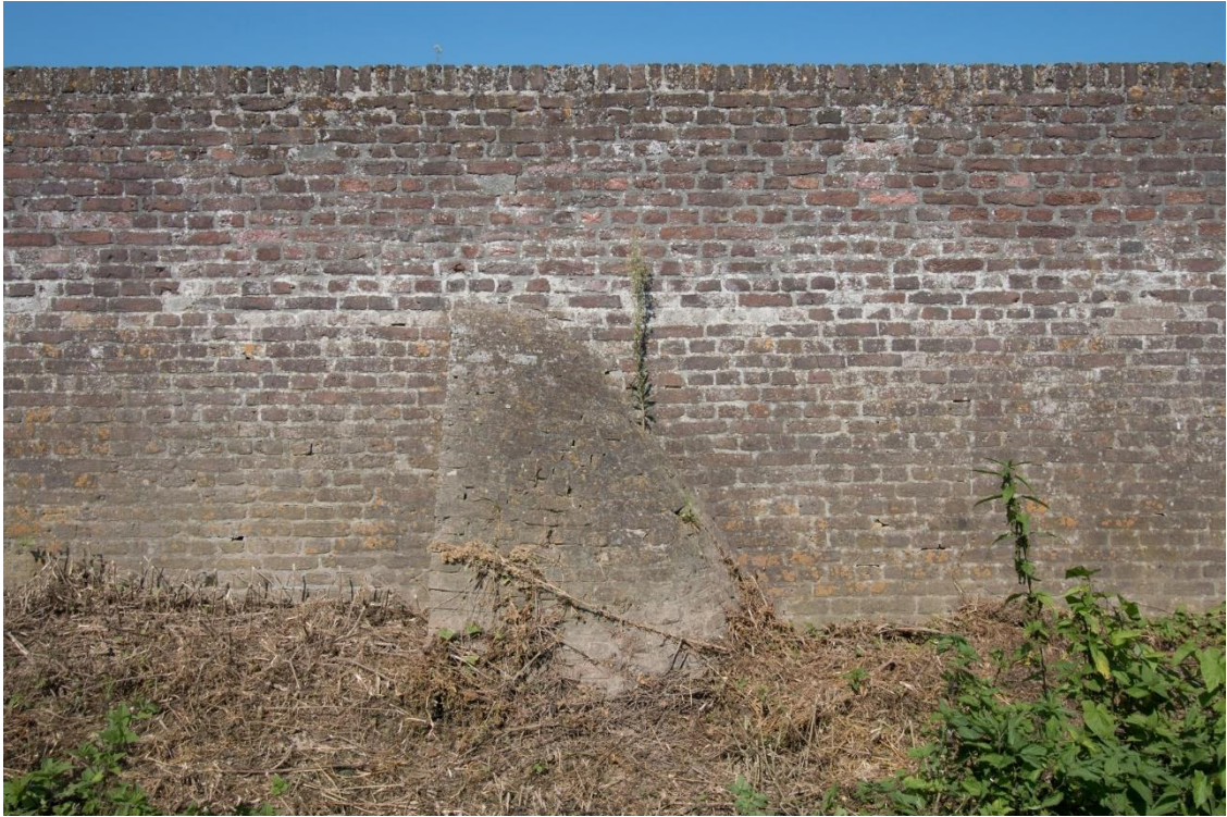
Sectie drie, de middelste steunbeer in vooraanzicht. De top van de steunbeer reikt tot aan de beëindiging van het uit het lood opgetrokken deel van de muur (en dus tot aan de hoogte van het grondpakket dat is opgebracht ten behoeve van de uitbreiding van het kerkhof).
