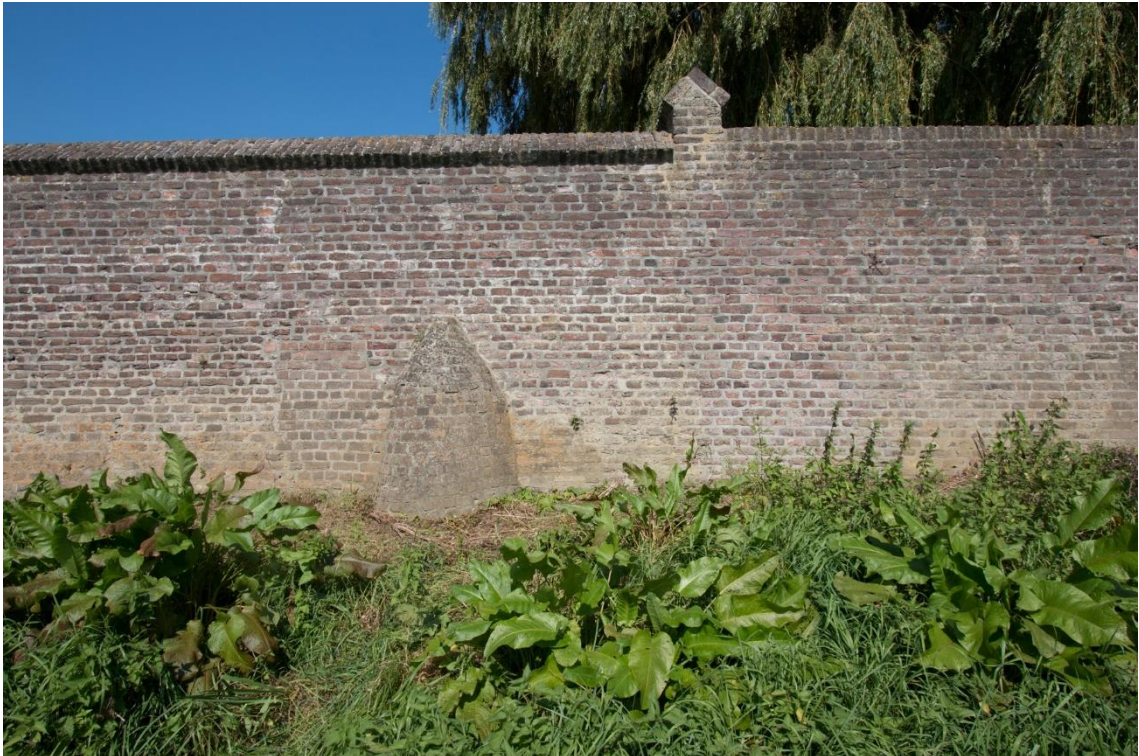
Muursectie één is meer dan de overige muursecties een lappendeken van (herstel)metselwerk. De muur gaat over van een afdekking met ezelsrug naar een afdekking met rollaag, ter plaatse van de huidige entree tot het kerkhof. In 1881 werd hier nog een brandspuithuisje tegen de muur tot stand gebracht (direct links van de opstand).
