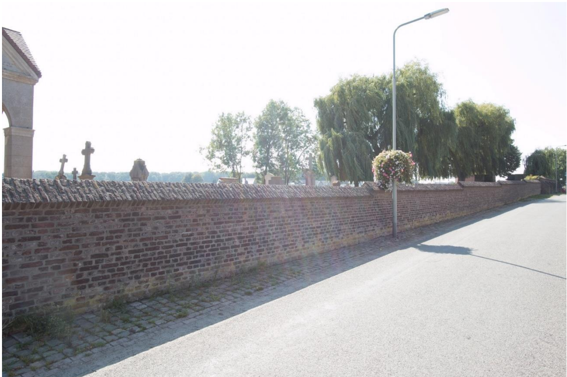
De schansmuur aan de straatzijde, afgedekt met ezelsrug, zoals ook de muren ter plaatse van de huidige Sint Vituskapel uit 1952-1954.
