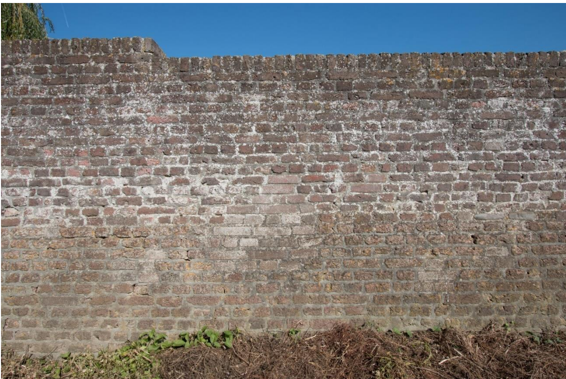
In het rechterdeel van de tweede sectie is de horizontale geleding minder regelmatig. Ook hier enkele plukjes recent inboetwerk.
