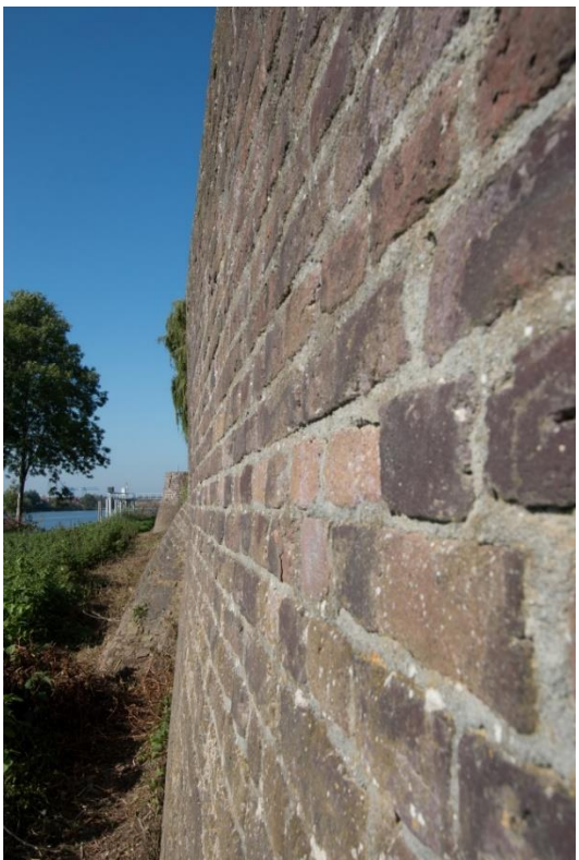
Sectie drie. Het deel van de muur dat de ten behoeve van het kerkhof opgeworpen grond keert, is – zoals te doen gebruikelijk – vier tot vijf graden uit het lood gemetseld. Omdat de grondkerende functie van de muur eindigt op circa 1,1 meter onder te top van de muur, is het in principe niet nodig om de steunberen hoger op te metselen.
