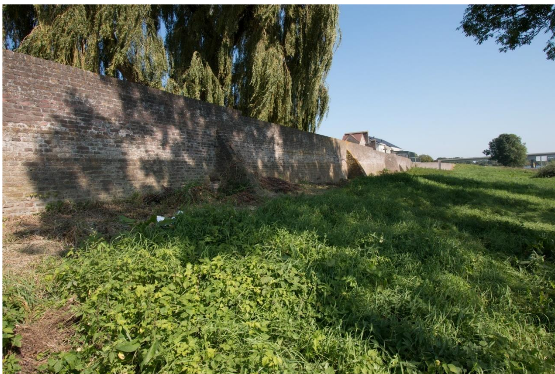
Muursectie twee gezien in noordoostelijke richting. De boom bevindt zich ongeveer ter hoogte van het gesloopte koor van de kerk.
