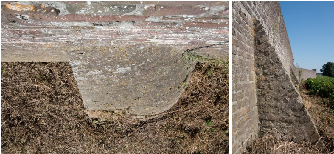
Sectie drie, de middelste steunbeer in zicht van bovenaf en het zijaanzicht vanuit het westen.
