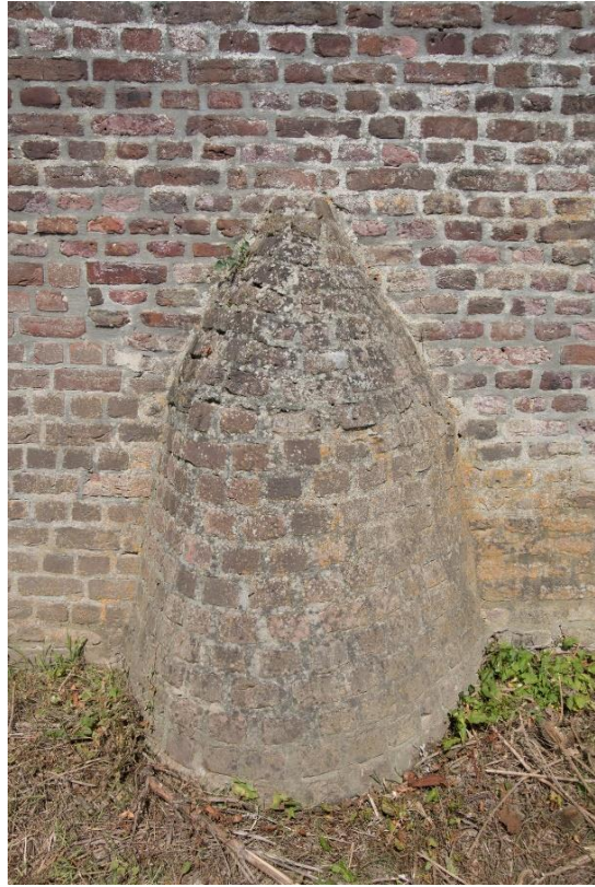
De overgang van het uit het lood gemetselde grond- en waterkerende deel van de muur en de opstand rondom het kerkhof, is duidelijk waarneembaar in muursectie één. De steunberenlijksbrekers ogen betrekkelijk klein, wat mede is bepaald doordat het maaiveldniveau hier relatief hoog is.
