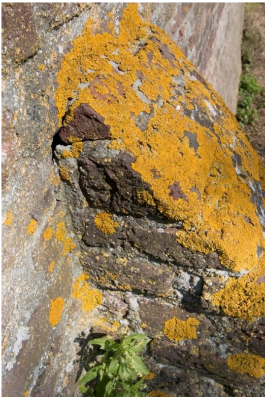
Door het schuin metselen van stenen, is het niet goed mogelijk om de top van de steunberen in verband te brengen met het muurwerk.
