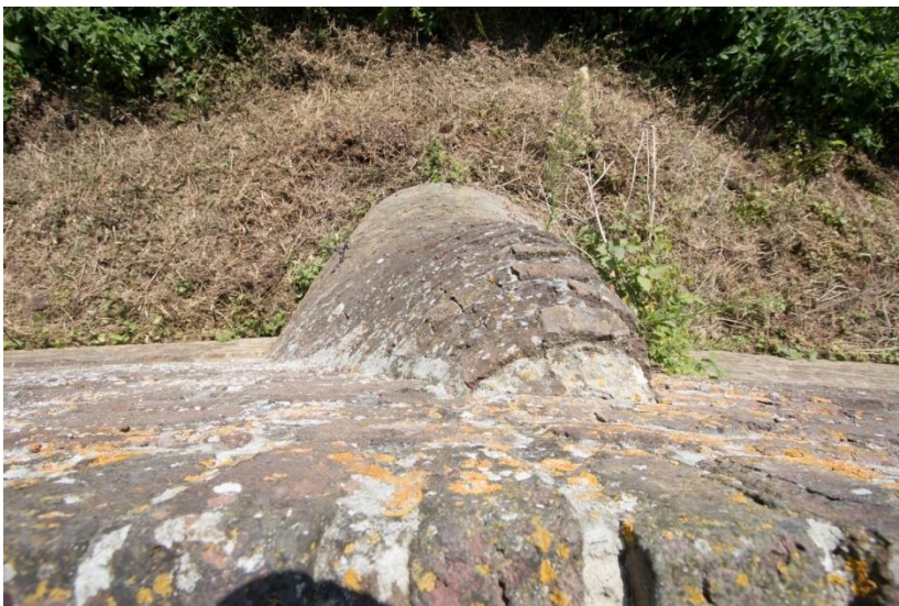
De steunbeer van bovenaf gezien. Ook hier valt de onregelmatigheid van met name de top op.
