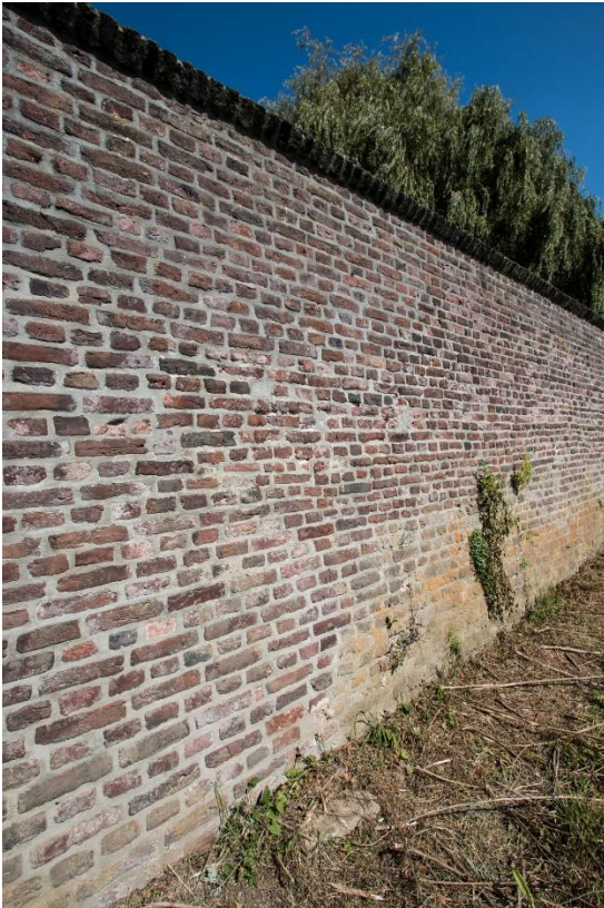
Het bovenste, paarskleurige metselwerk op de foto links is vrijwel zeker de herstelling van de oorlogsschade uit 1944 die we zien op de foto rechts. Archief Well, alle historie over het dorp Well Limburg
