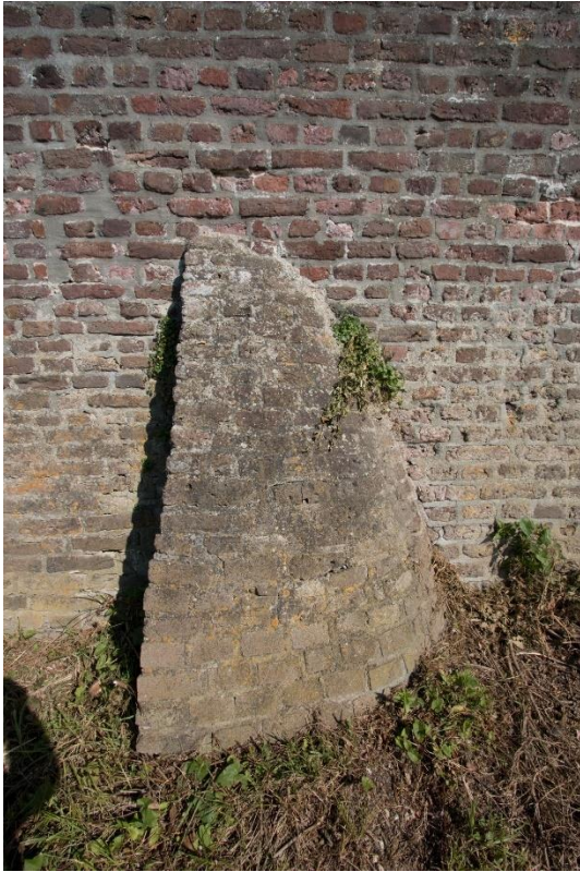
De rechter steunbeer van muursectie één wijkt in grondvorm af van de linker steunbeer in deze muursectie en in detaillering van de steunberenlijsbrekers van muursectie twee, waar vlechtingen zijn uitgevoerd.
