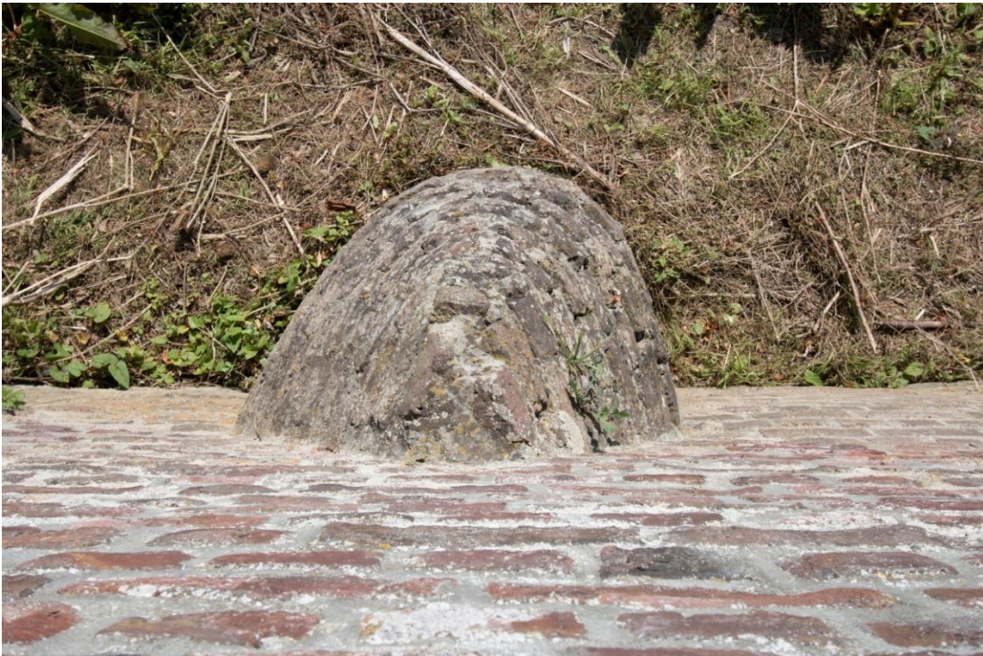
Bovenaanzicht van de linker steunbeer, die in tegenstelling tot vergelijkbare steunberenlijksbrekers, een vlakke zijde ontbeert.
