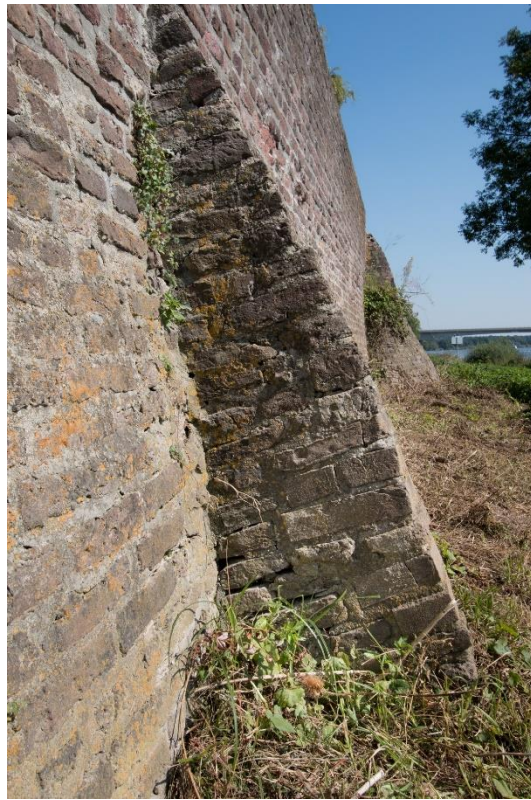
De rechter steunbeer van muursectie één wijkt in grondvorm af van de linker steunbeer in deze muursectie en in detaillering van de steunberenlijsbrekers van muursectie twee, waar vlechtingen zijn uitgevoerd.
