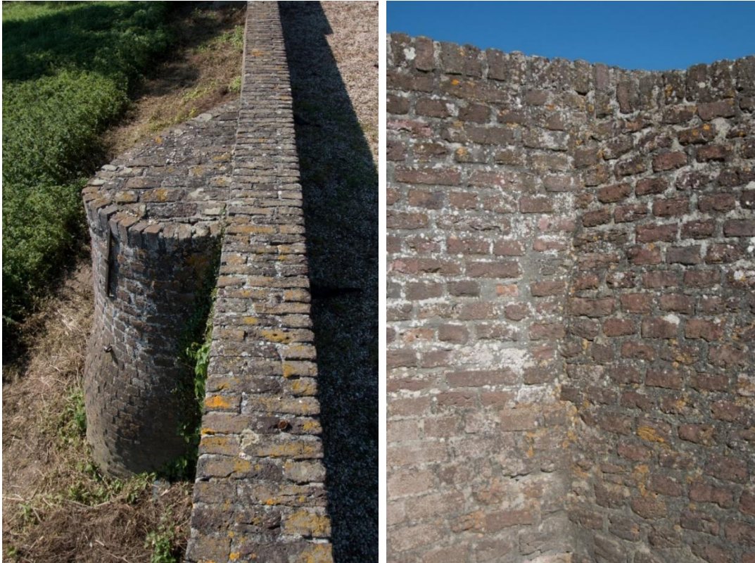
Dat de steunbeer in huidige toestand ten minste in twee fasen is opgetrokken, is vrij goed te zien wanneer schuin op de steunbeer wordt gekeken. Het bovenste deel is duidelijk in verband gemetseld met het bovenste deel van de muur. Voor het metselwerk daaronder is dit lastiger vast te stellen, maar het heeft er wel alle schijn van.
