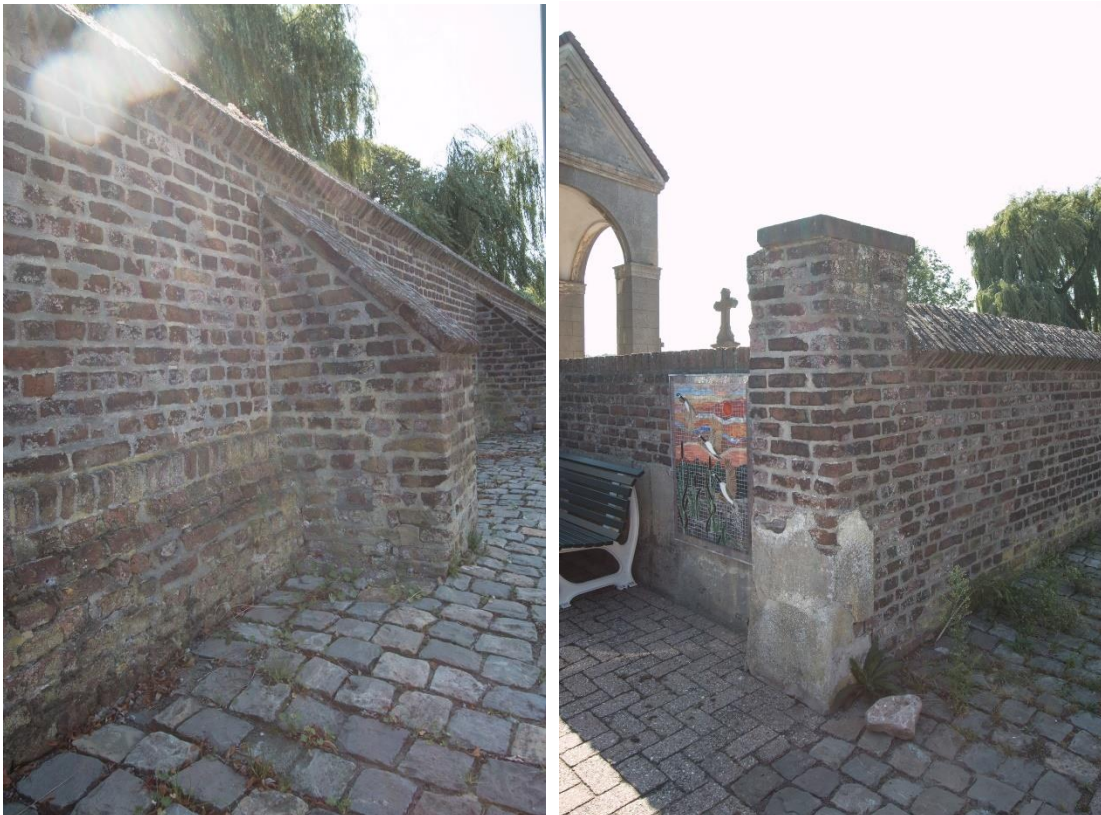
Links de deels opnieuw gemetselde aanzetten van de vermoedelijk achttiende-eeuwse steunberen. Rechts zien we op de hoek nog één met natuursteen afgedekte pilaster, die echter nieuw opgemaakt lijkt te zijn.
