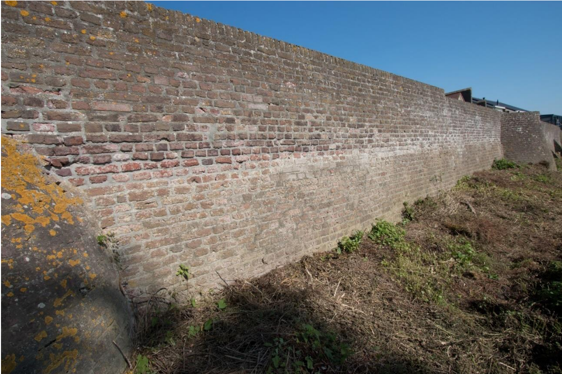
Het rechterdeel van de tweede muursectie buikt veel minder uit, mogelijk omdat dit deel van de muur langs het vroegere kerkgebouw doorsteekt.
