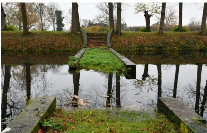
Figuur 4.25: Huidige betonnen verbinding over buitengracht
