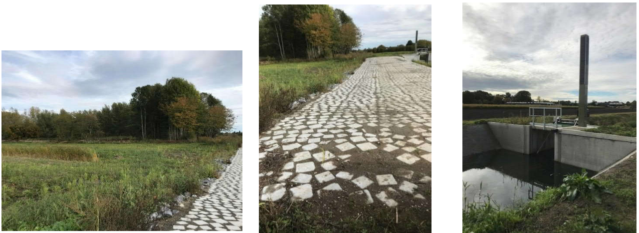
Figuur 6 Impressie overloopgebied de Baendj met de betonnen instroomvoorziening en rechts de stuwconstructie die ophoog gaat bij hoog water (knijpvoorziening)
