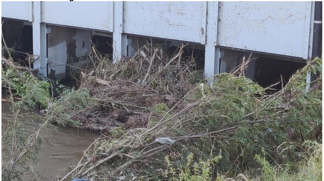
Figuur C.14 Drijfvuil bij de inlaat van de sifon na afloop van het hoogwater. Foto ontvangen van Waterschap Limburg
