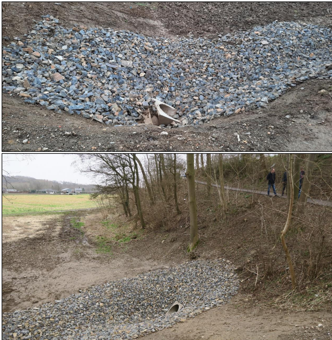
Figuur 3.14 Foto's van de duiker na het hoogwater op 4 februari 2022. De grond rondom de duikers is vrij gegraven en de bodem is verdedigd. Boven: Zuidkant van de brug (foto: J. de Jong), Onder: noordkant van de brug (foto: N. Asselman)
