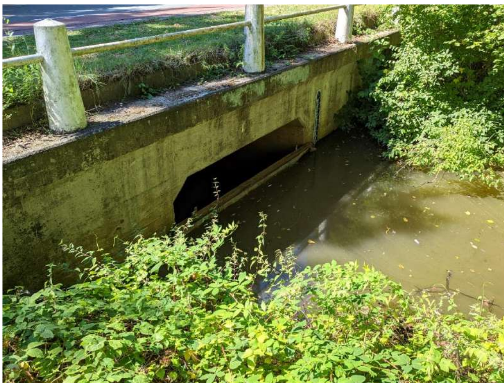
Afbeelding 7. De vanwege droogte dichtgezette stuw in de Lingsforterbeek bij de Lingsforterweg (foto genomen op 09-08-2022).
