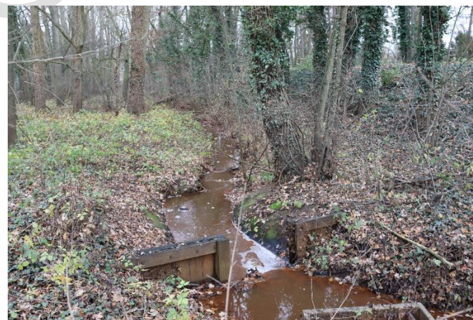
Afb. 83 Rechts de dijk met de Schans. Meteen nadat de beek onder de weg uitkomt, is er een (moderne) sluis/doorvoer. Bron: Foto door auteur.
