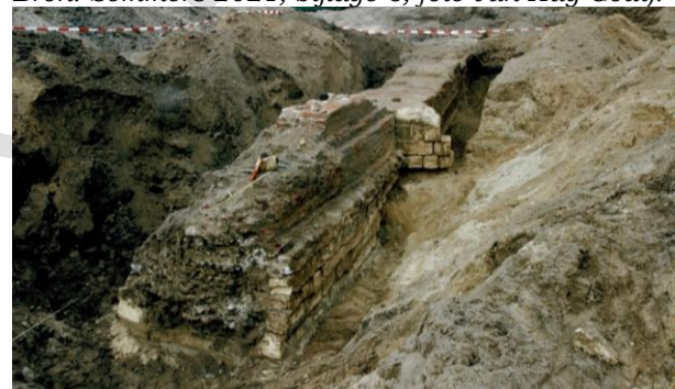
Afb. 22 Aangetroffen stadsmuur bij voorbereidende werkzaamheden bij Maashotel. Bron: Sommers 2021, bijlage 6, foto van Hay Gout).
