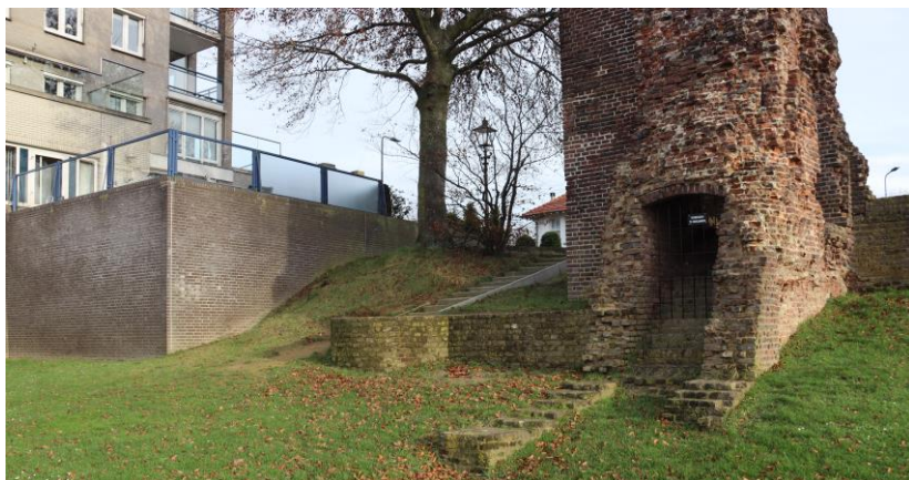
Afb. 18 Schanstoren en noordelijke stadsmuur met rondeel. De reconstructie dateert uit de jaren tachtig.
