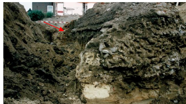
Afb. 21 Aangetroffen stadsmuur bij voorbereidende werkzaamheden bij Maashotel. De rode pijl wijst een steunbeer aan. Bron: Sommers 2021, bijlage 6, foto van Hay Gout).
