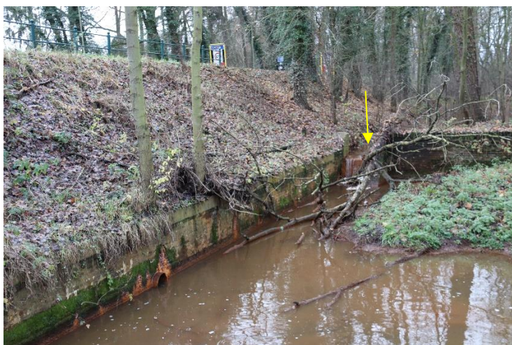
Afb. 81 De Molenbeek, gezien vanaf het terras van de Wijmarsche watermolen. Op de achtergrond de keermuur met sluis (gele pijl). Ruwweg ter hoogte van deze keermuur moet ergens de 1,7 meter dikke muur in het talud zitten.
