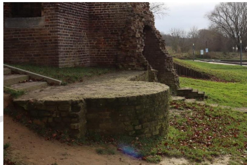
Afb. 19 Bij de reconstructie is de oude, diagonale muur niet gereconstrueerd en zijn het rondeel en de jongere muur als één samenhangend geheel opgemetseld, waardoor de historische gelaagdheid is verstoord.
