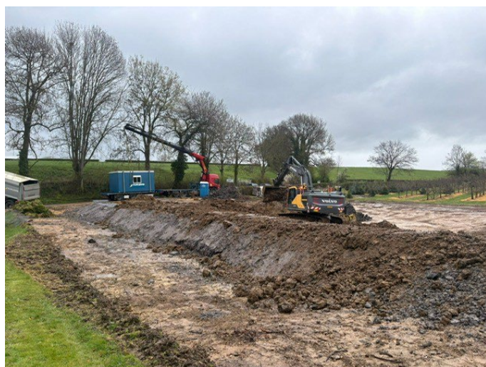
Aanleg buffer Vroelen
