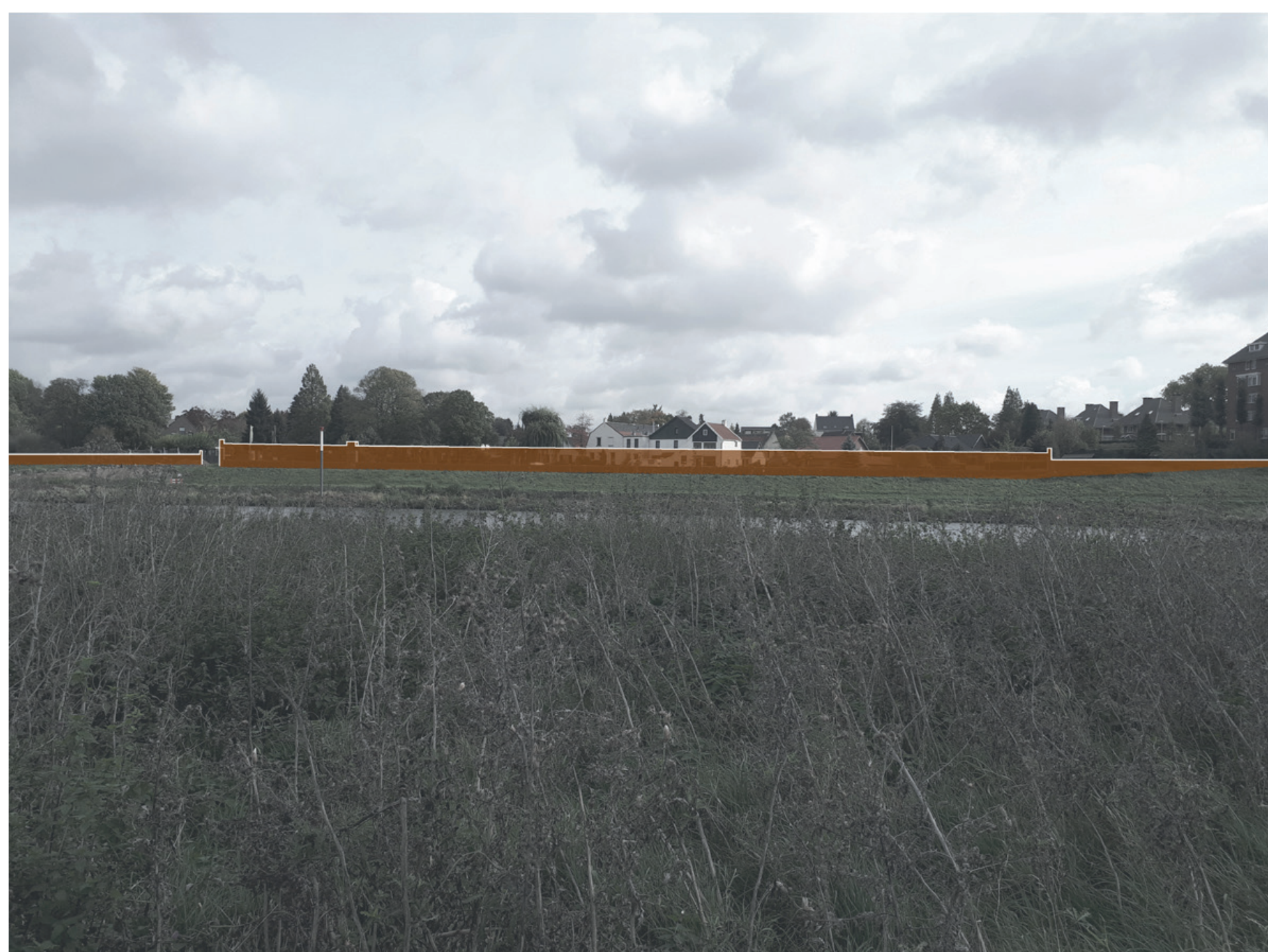
Overkant: demontabele kering (drempel 21.0 NAP)
