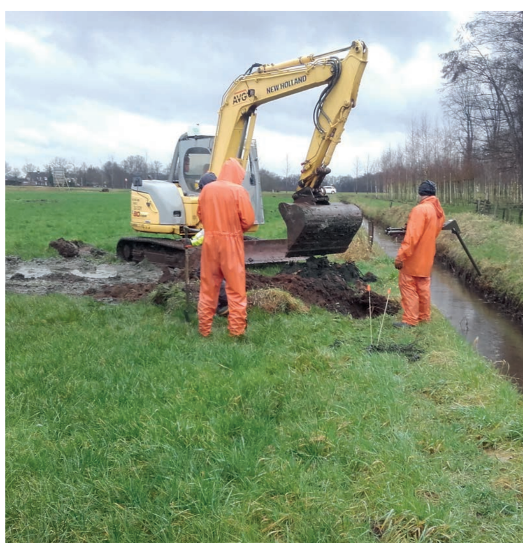
Kabels en leidingen onderzoek
