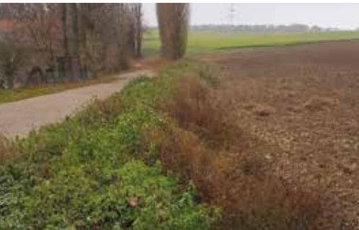
Gaston Backbier 2018 | Aanleg dijk (rood op kaartje) voor remmen piekafvoer water uit bovenliggende percelen (circa 15 ha) ter bescherming hoeve. Perceel-deel voor de dijk is buffergebied, mei 2018 water gebufferd met schade aan bietengewas.
