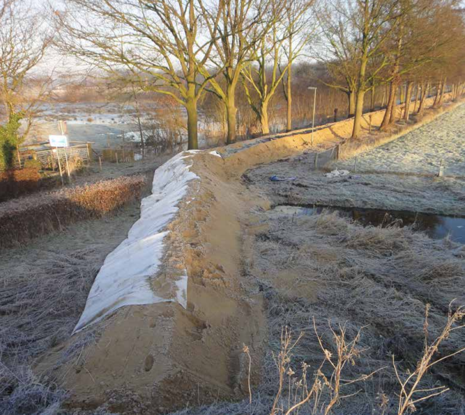
De huidige dijktracés ontstonden als haastig antwoord op individuele belangen. Er kan bij deze dijkversterkingsopgave niet worden voortgeboord op deze waterkeringen
