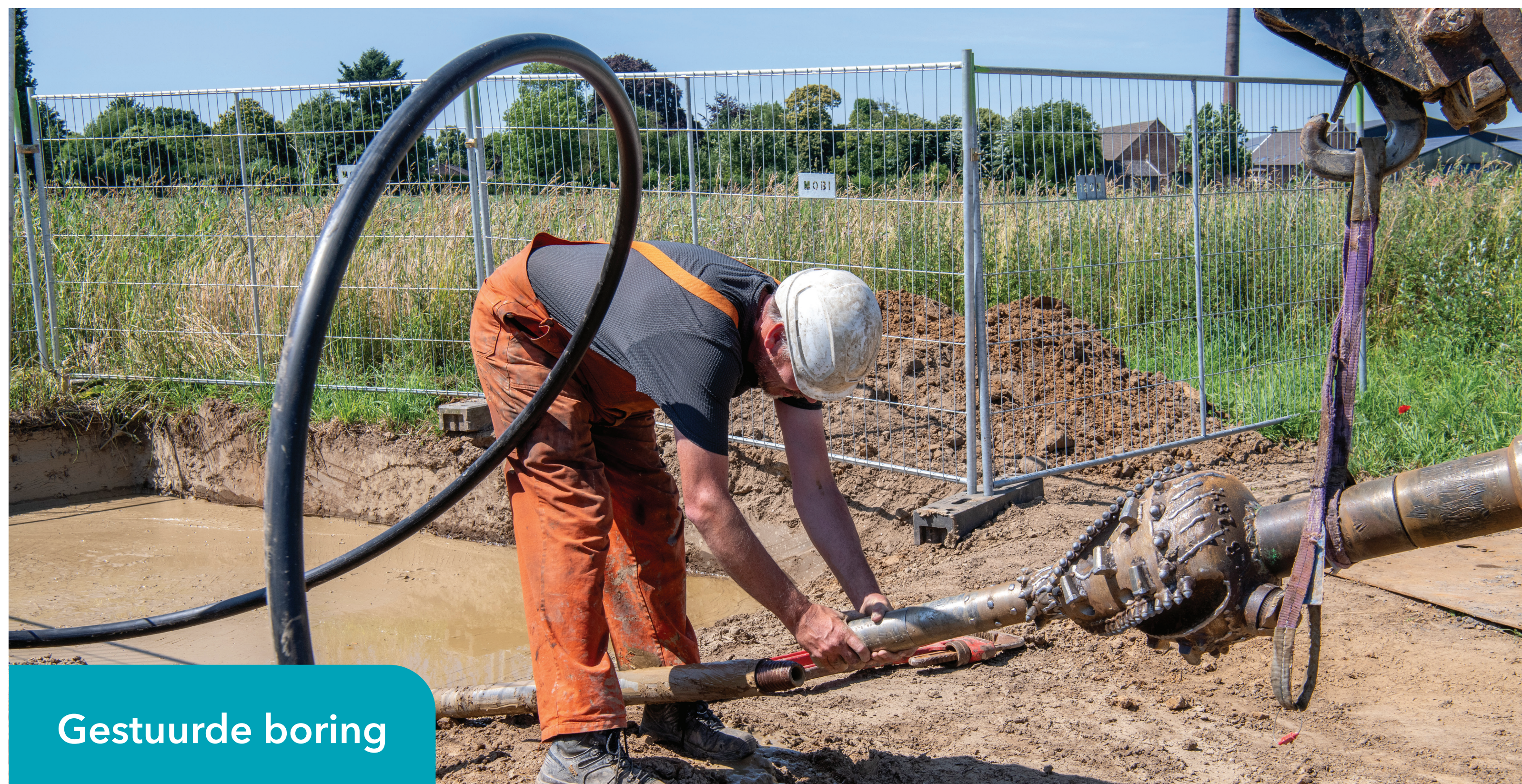
Uitvoering van de gestuurde boring
