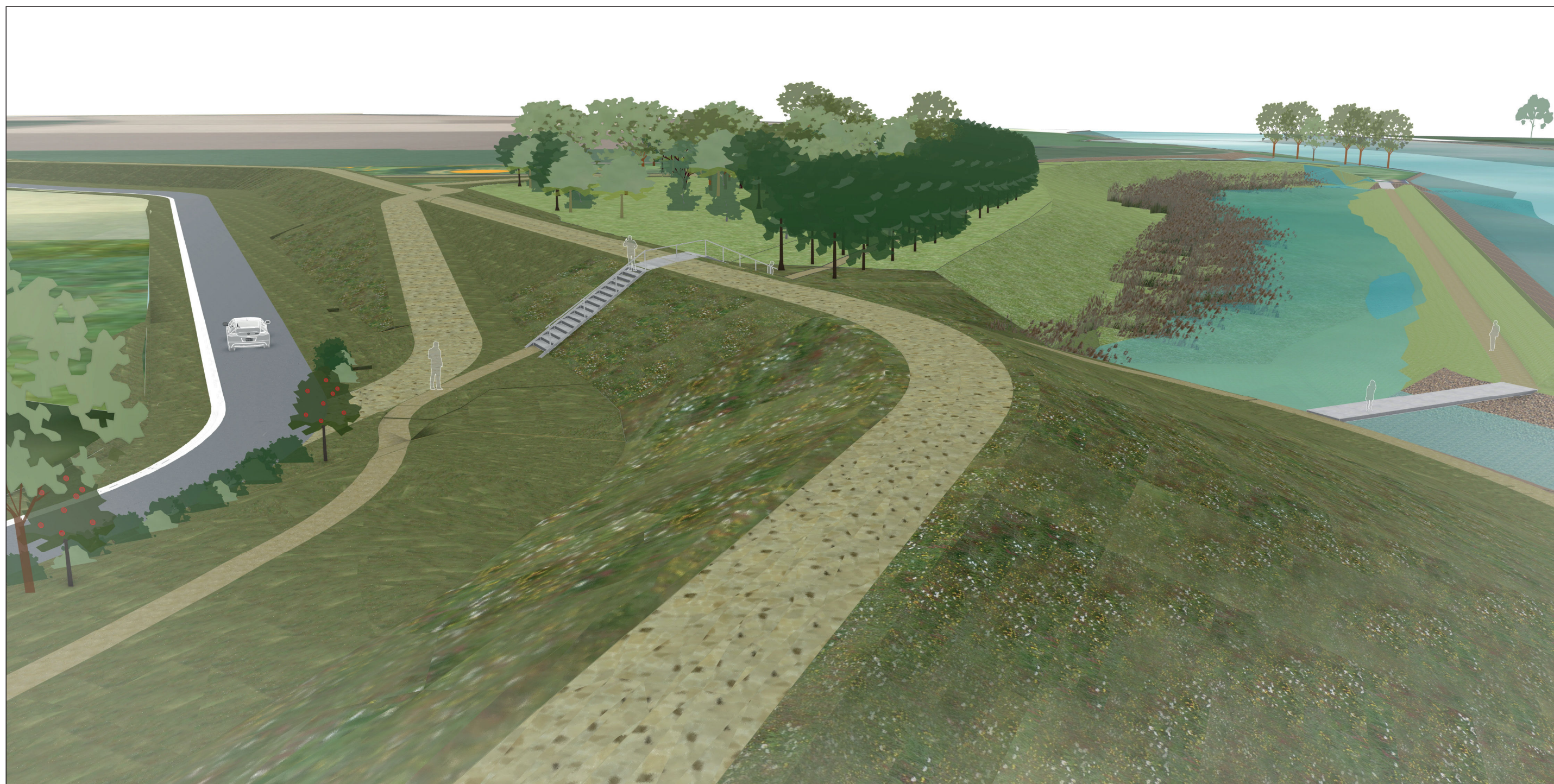
Aanzicht dijkruin ter hoogte van voormalige coupeure, dijktrappen verbinden het wandelpad van binnen- naar buitendijks.
