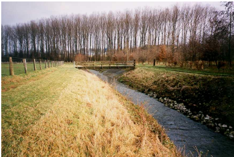
De Geleenbeek is op vele plaatsen rechtgetrokken en vastgelegd in stortstenen: klasse 7. De beek heeft een algemeen ecologische functie.
