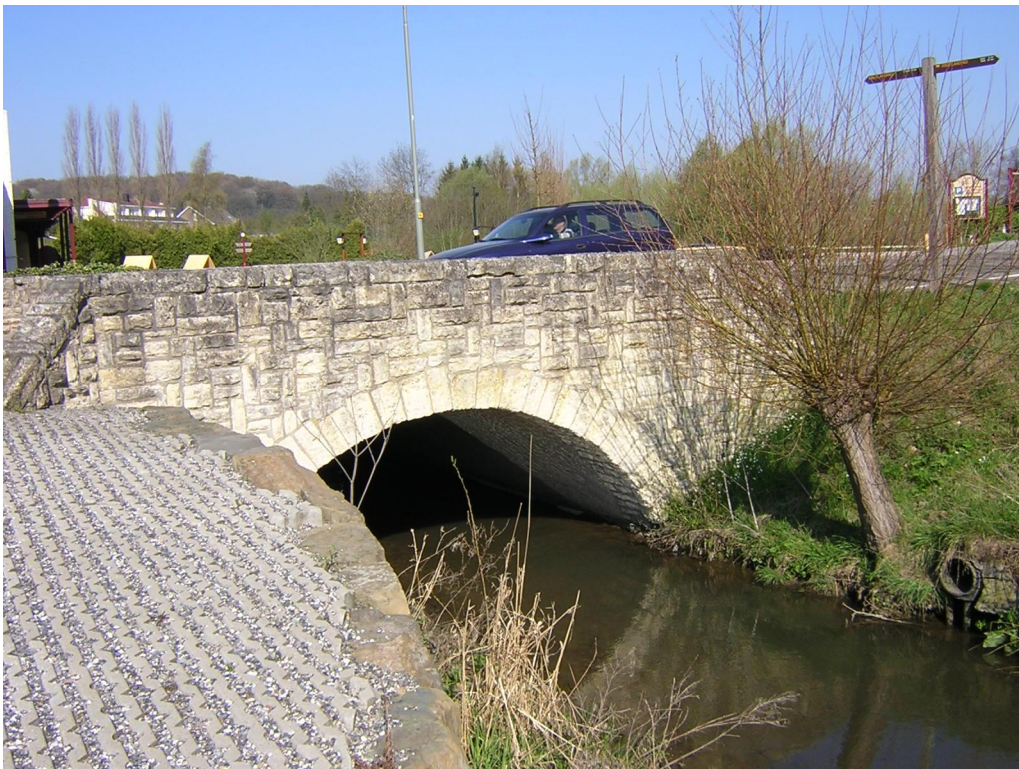
Figuur 5.7 De Slenakerbrug, gezien vanaf de zuidzijde (bron waterschap)
