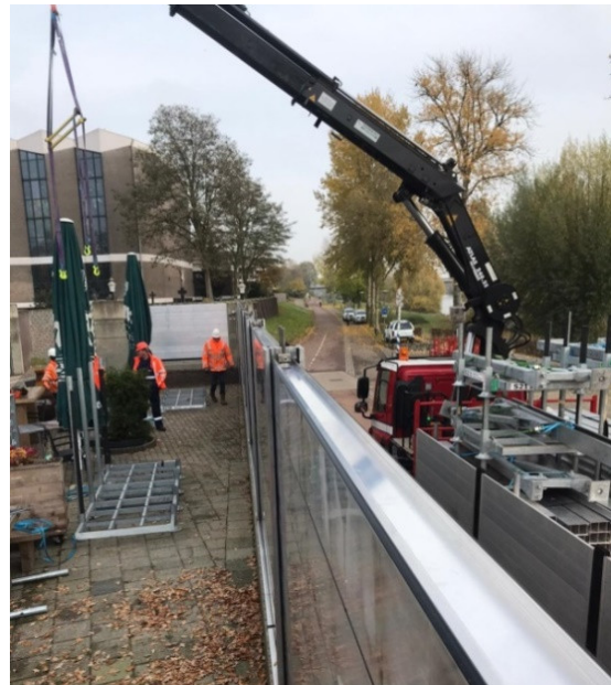
Opbouw van demontabele waterkering in Blerick
