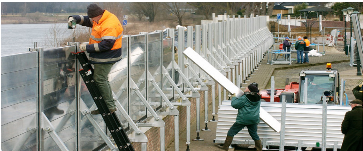
Testen opbouw demontabele kering
