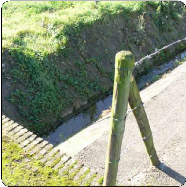
Begin overkluizing Luiperbeek
