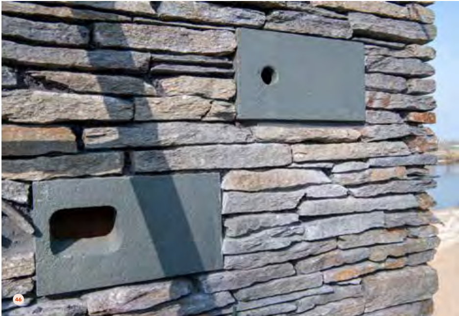
46 De poortgebouwen van de zelfsluitende waterkering zijn voorzien van ecologische voorzieningen voor insecten, vogels en vleermuizen. Ook zijn ze bekleed met natuursteen, gerecyclede bakstenen en dakpannen waarop flora en fauna zich verder kan ontwikkelen.
