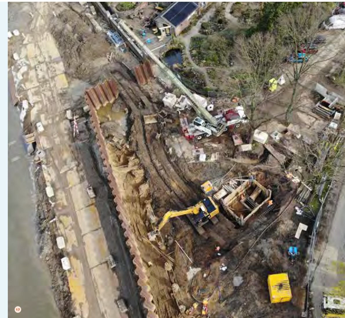
17 De werkzaamheden aan de overstortleiding waren een complex onderdeel van het werk. Op 7 meter diepte moest de leiding worden vervangen en tussen de palen van de bakconstructie en door de damwand doorgevoerd. En dat met de geringe ruimte én tijdens het hoogwaterseizoen
