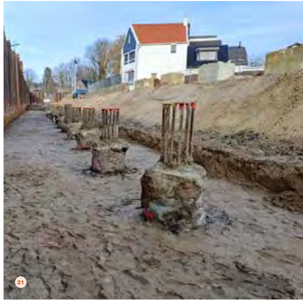
21 De stekwapening die uit de paalkoppen steekt, wordt gebruikt om de palen constructief te verbinden met de vloer.
