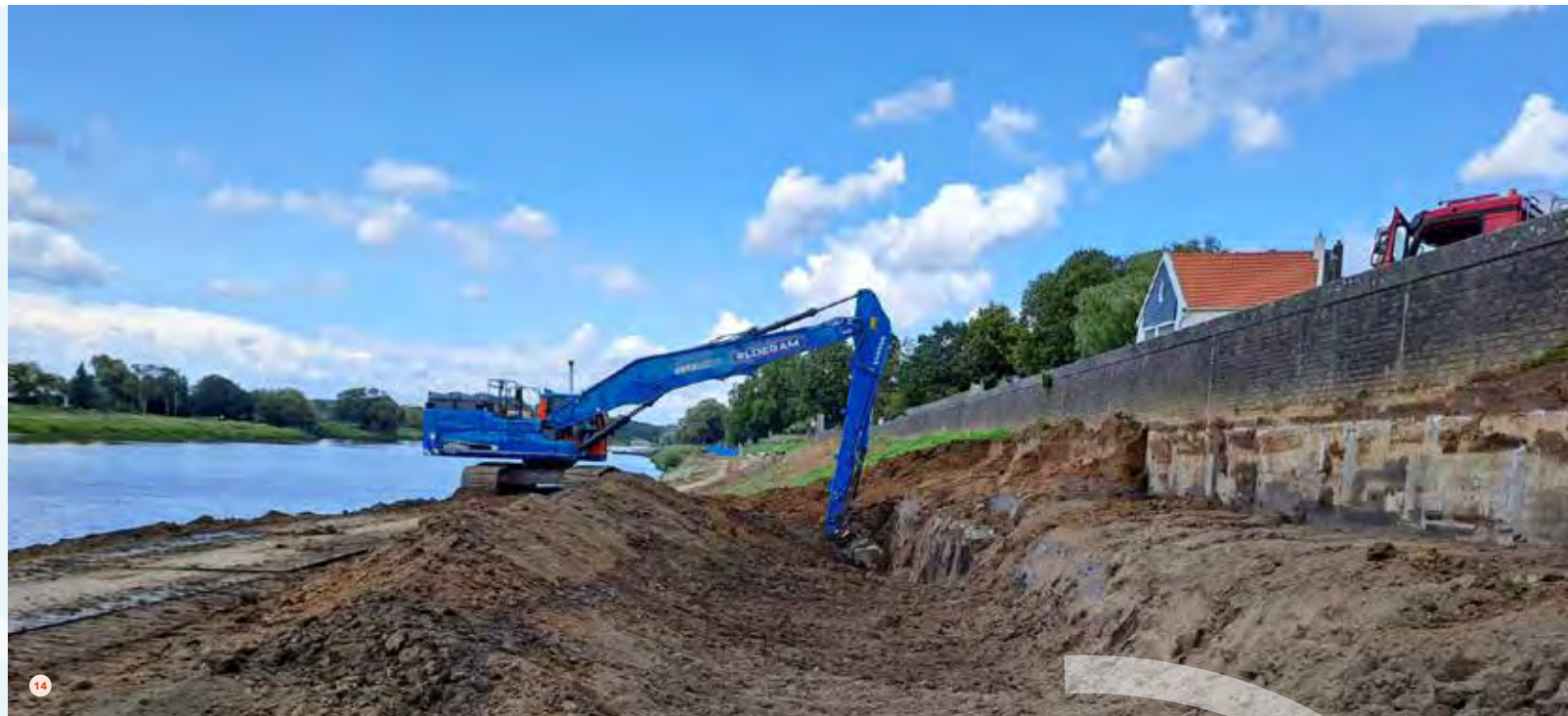
14 Voordat de zelfsluitende kering kan worden aangelegd, moet eerst de persleiding verplaatst worden. Deze ligt nu dicht bij de Maas.
