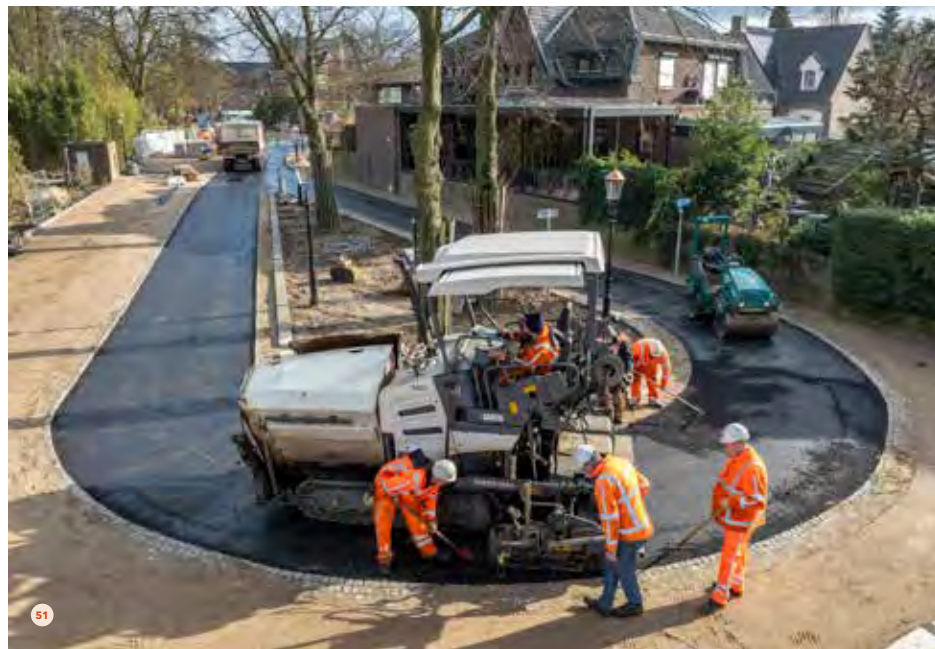
51 52 Februari 2025 — In februari 2025 wordt het asfalt aangebracht.
