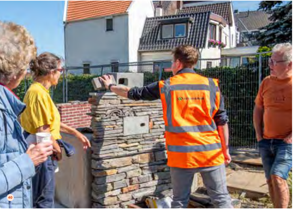
39 40 Juni 2024 – Tijdens de Dag van Bouw was de bouwplaats voor iedereen open. Ruim 200 geïnteresseerden brachten een bezoek aan de bouwplaats in Steyl.
