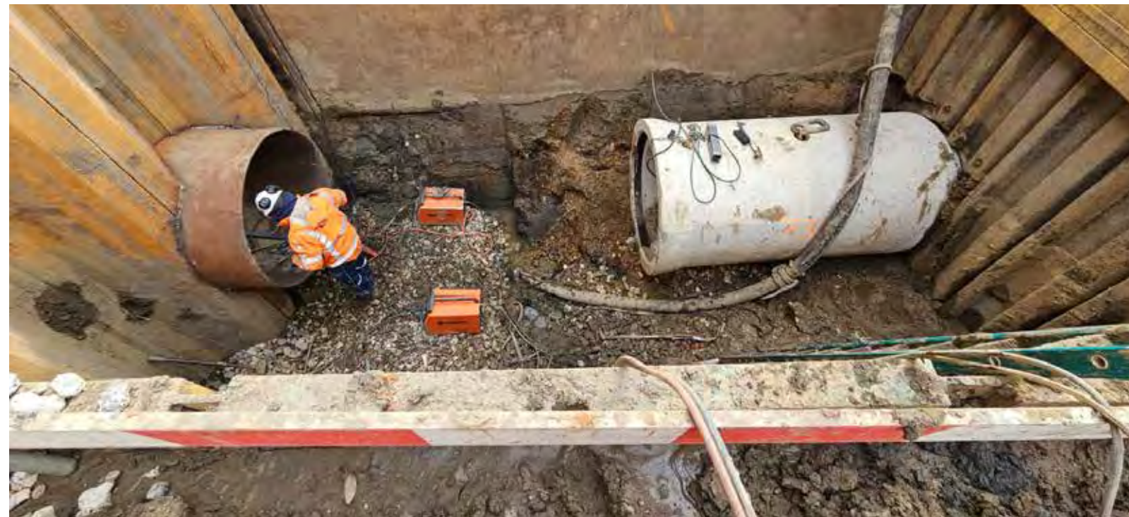
15 In maart 2024 wordt de diepgelegen overstortriolering via een ingelaste stalen mantelbuis door de nieuwe stalen damwand gevoerd. Tijdelijke sleufbekisting en bronbemaling zorgen daarbij voor een veilige en droge werkplek.
