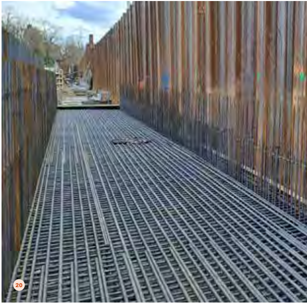
20 De vloerwapening en de stekwapening voor de wanddelen van de betonnen bak zijn aangebracht.
