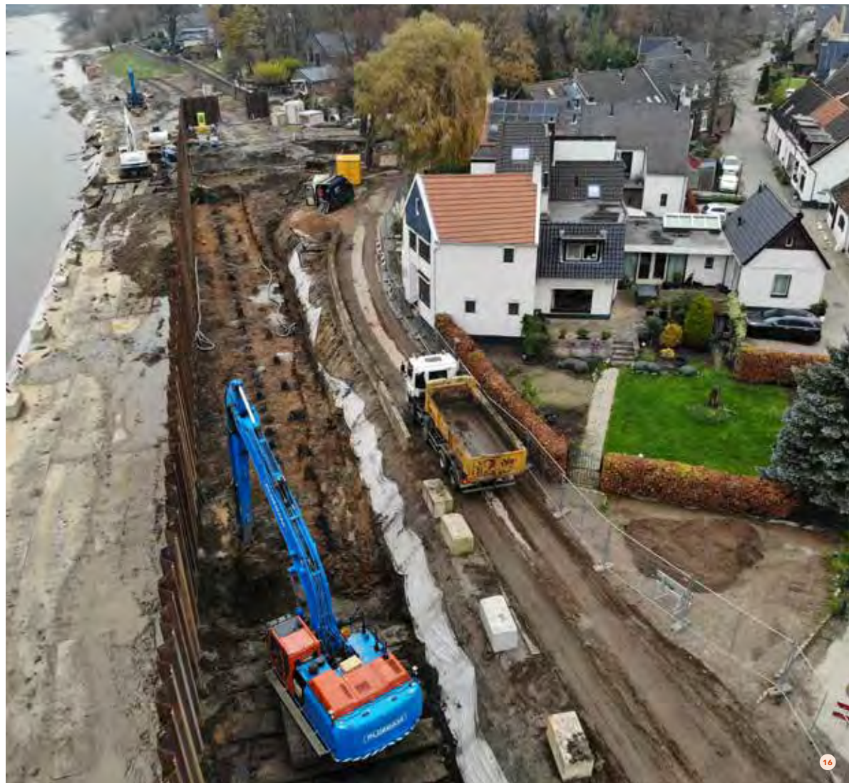
16 Werken op een postzegel: zo noemen we het werken in Steyl soms ook wel. Zoals te zien op deze foto hadden we in deze fase alle beschikbare ruimte nodig voor de werkzaamheden.
