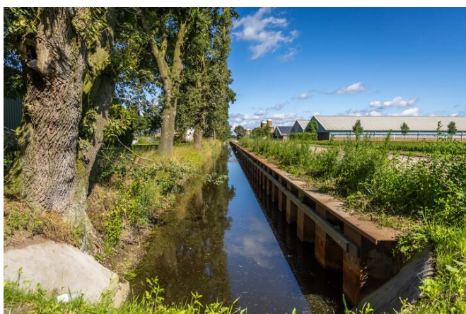
Figuur 2 Boabel met solitaire zomereiken in het westelijk talud en een stalen damwand als oostelijke oever parallel langs de Nieuwenhofweg.
