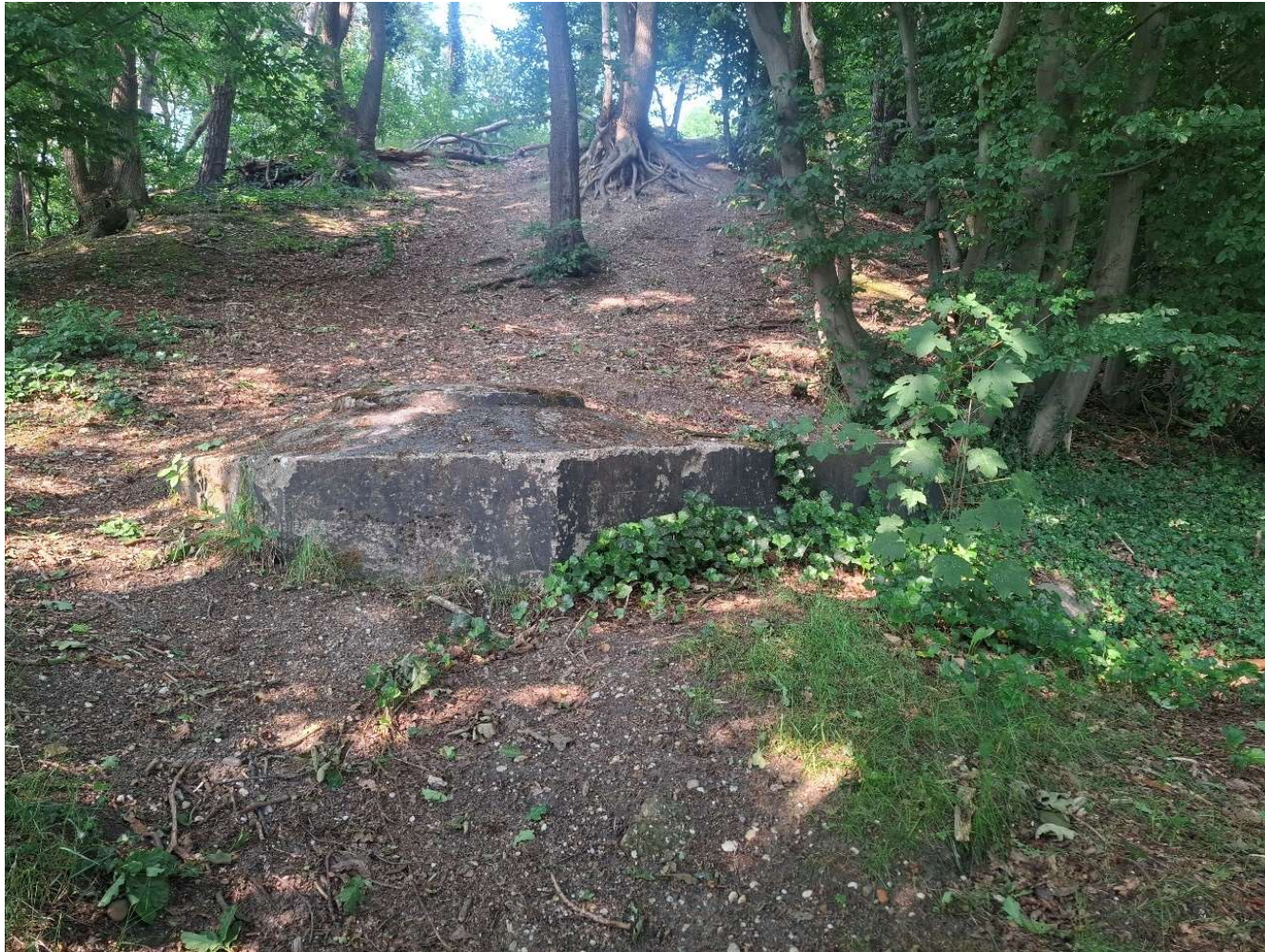
Figuur 56 De ringstandbunker op de hoek van het Hoogterras aan de overzijde van Hoeve Maalbeek.
