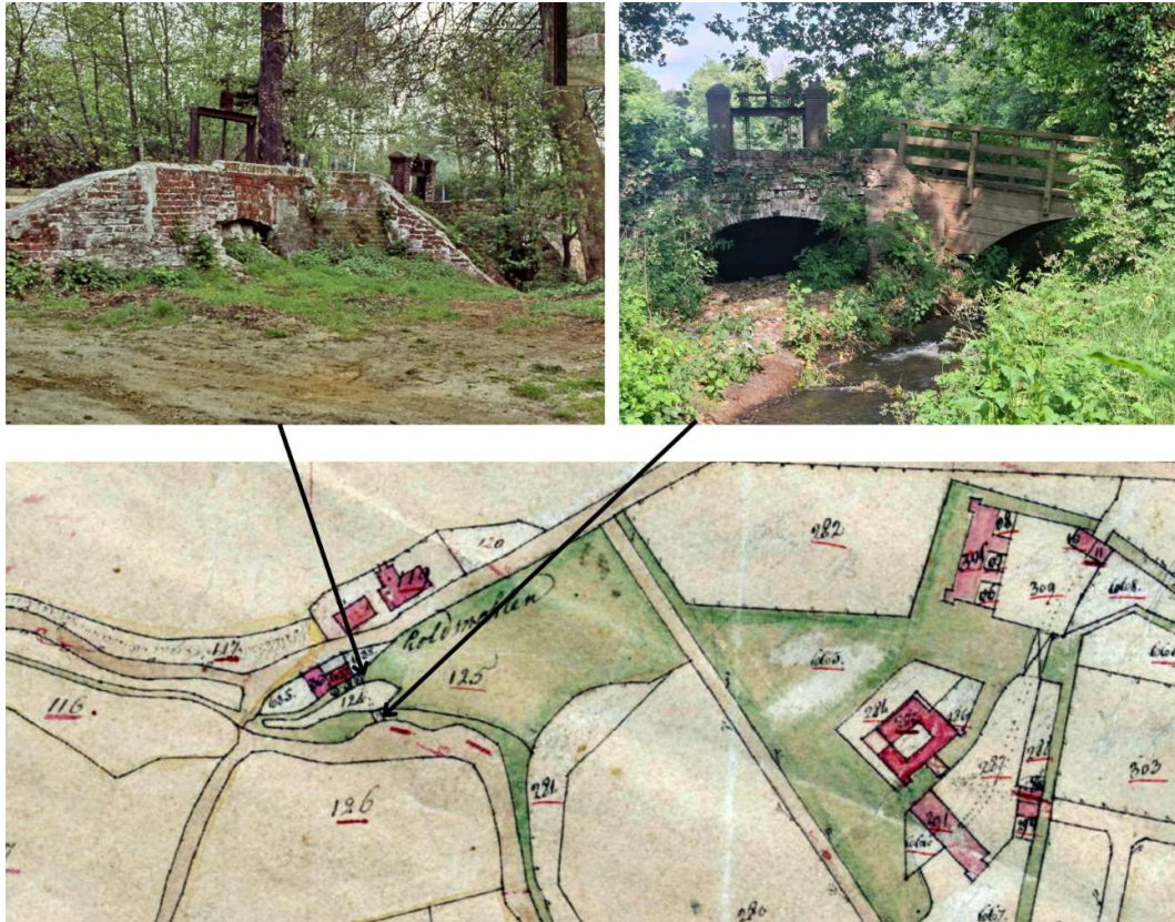
Figuur 11. De sluiswerken van de voormalige Holtmeulen in de gedempte watergang links ( www.alledolens.nl ), en het functioneel sluiswerk in rechts (foto gemaakt op 3-6-2025).
