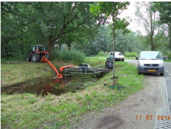
Afbeelding 28: Links: Noodbemaling i.v.m. storing gemaal lavendel in Griendsveen. Rechts: Extra capaciteit voor gemaal Beukenhof.
