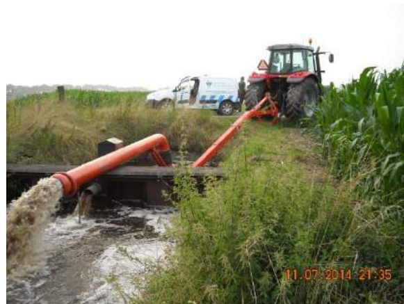
Afbeelding 28: Links: Noodbemaling i.v.m. storing gemaal lavendel in Griendsveen. Rechts: Extra capaciteit voor gemaal Beukenhof.
