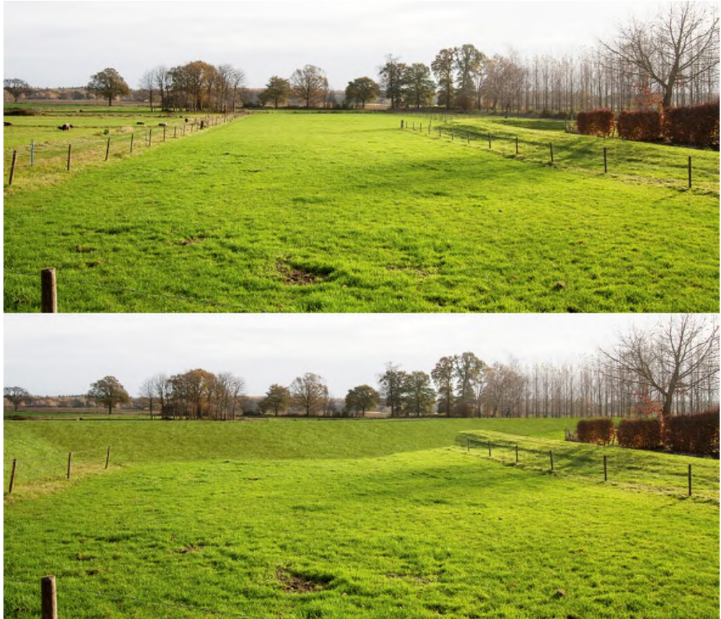
Figuur 5-7 Visualisatie van het dijkontwerp Lottum, standpunt Pastoor Kerboschlaan, kijkend naar de Maas. De bovenste foto is de huidige situatie, in de onderste foto is het dijkontwerp ingetekend.
